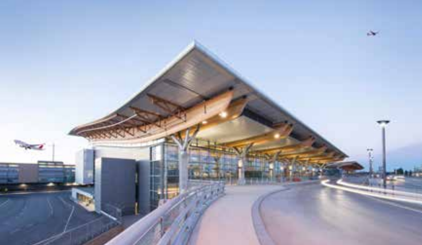
Gardemoen sentralbygning vest. Foto: Peter Leenders
