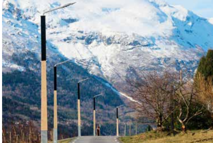
Lysmaster med solceller. Foto: BTG.
